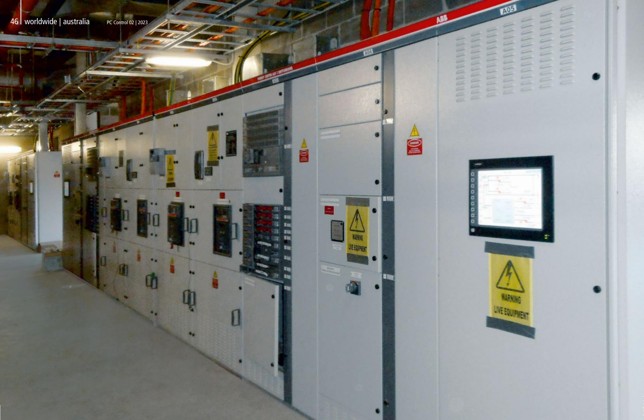
Durch die EtherCAT-Kommunikation konnte der Umfang der Anlagenverkabelung verringert und die Größe der zentralen Steuerungsanlage auf eine Schaltschrankreihe reduziert werden.
