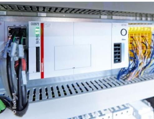
Der Embedded-PC CX2072 mit direkt angereichten EtherCAT- und TwinSAFE-Klemmen steuert alle Bewegungs- und Prüfbläufe.
