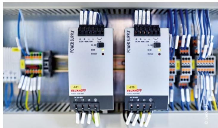
Die Stromversorgungen PS3031-2420-0001 – 3-phasige, 24-V-DC-Geräte mit 20 A Ausgangsstrom und 480 W Ausgangsleistung – versorgen zuverlässig die Steuerungstechnik und wirken sich mit hohem Wirkungsgrad und geringem Wärmeverlust positiv auf Anlagenverfügbarkeit und Energiekosten aus.
