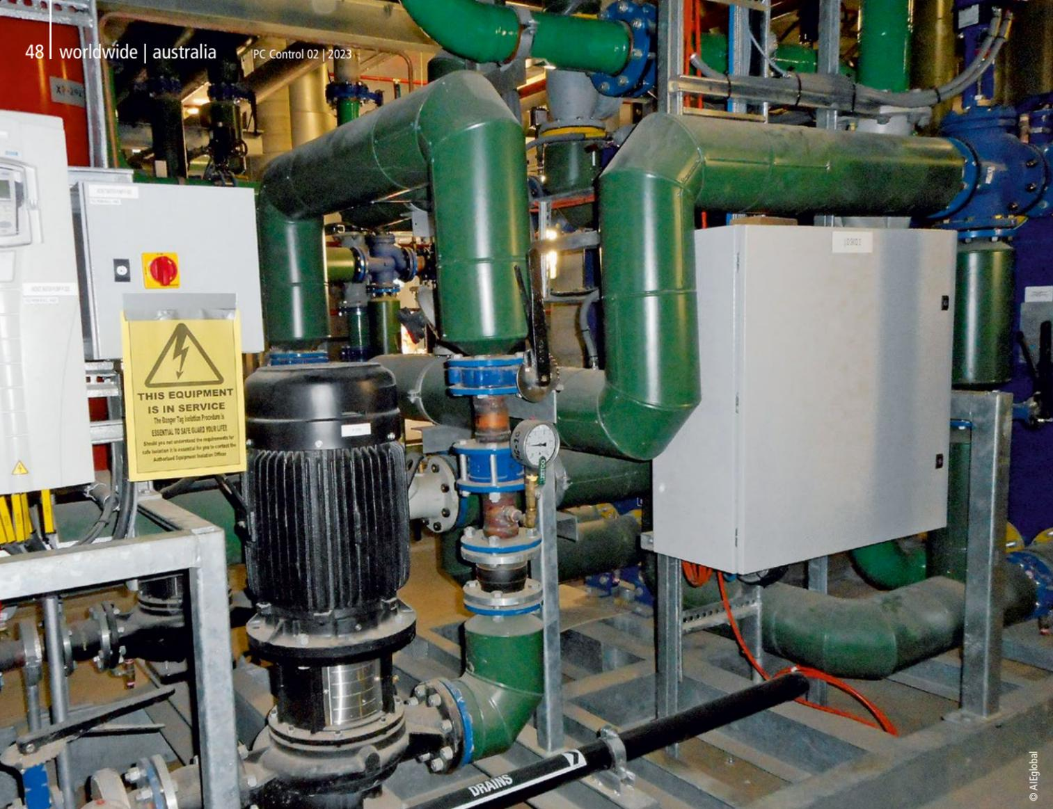
Die an jedem Aggregat installierten EtherCAT-I/Os reduzierten den Verkabelungsaufwand für die Verbindungen mit dem zentralen Kontrollraum erheblich.
